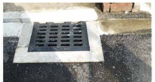
水が溜まっていた所に雨水マスが実現
