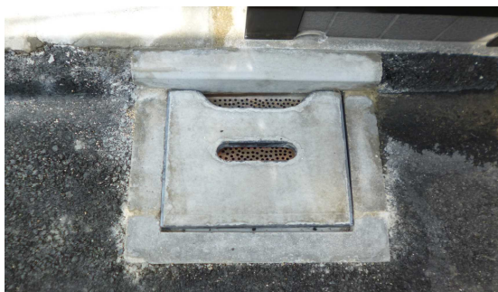
排水マスができました（東和学区）
