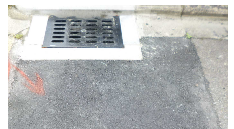
穴が空いて道の下が空洞に。漏水で土が流されていたことが判明。改修工事が実現（唐橋学区）。
