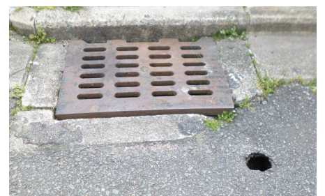
穴が空いて道の下が空洞に。漏水で土が流されていたことが判明。改修工事が実現（唐橋学区）。
