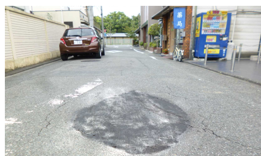
陥没していた道路の緊急補修
