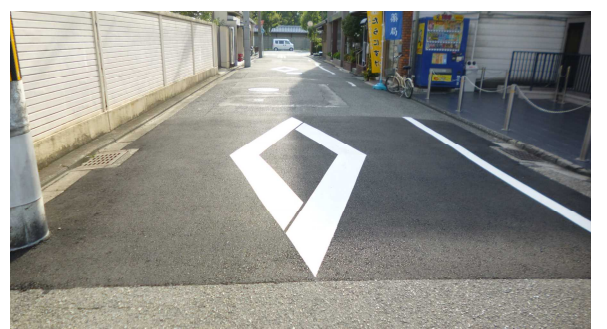
道路の穴の改修が実現 (九条学区)
